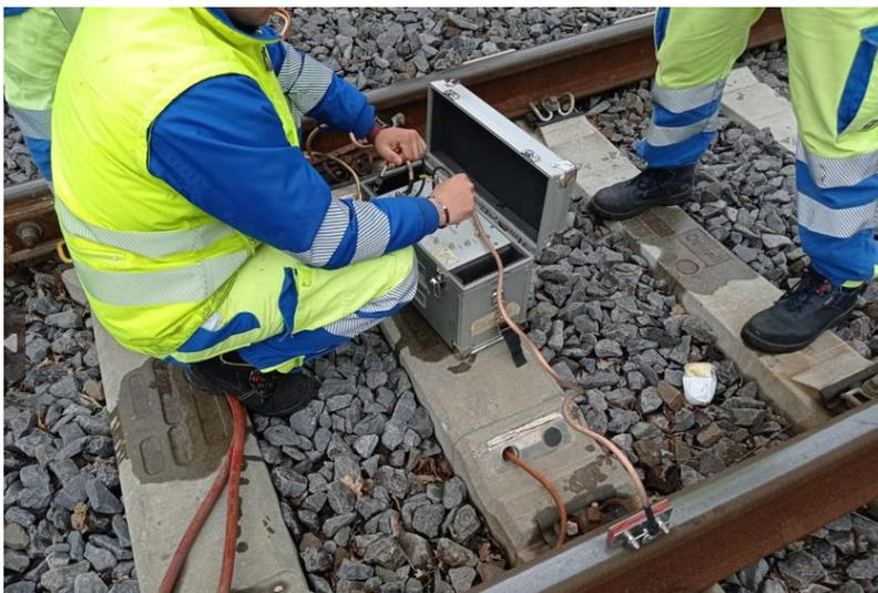
***AF.I – Verifica dello stato delle apparecchiature del PL: barriere, dispositivi luminosi ed acustici, casse di manovra e relativo posizionamento rispetto alla carreggiata, trefoli di guardia e linea di contatto, etc (12 elementi di controllo)***
